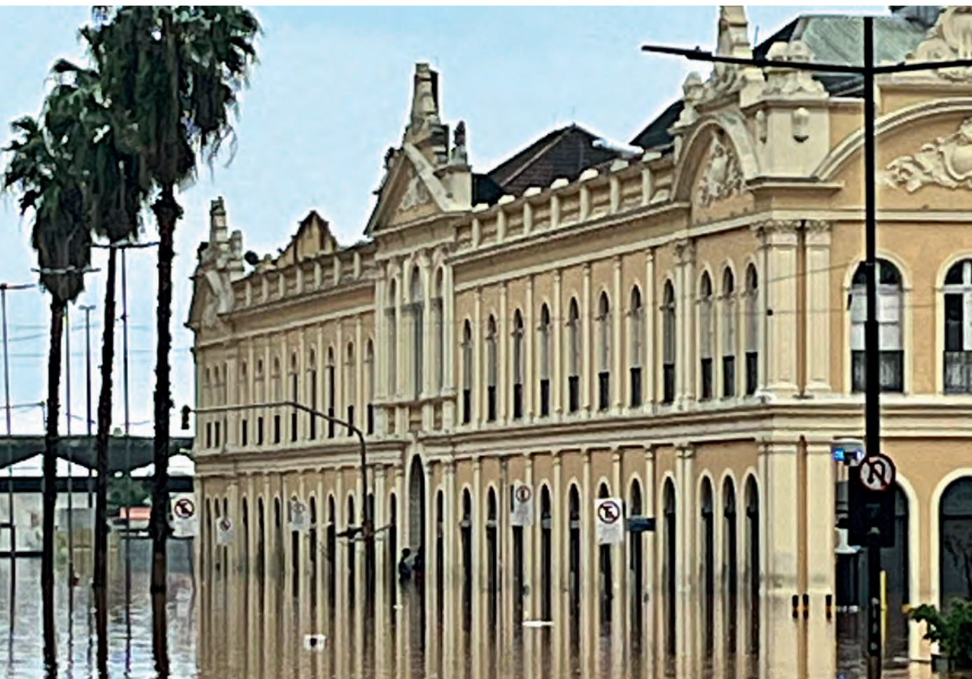
Mercado Público de Porto Alegre com o primeiro pavimento alagado.
