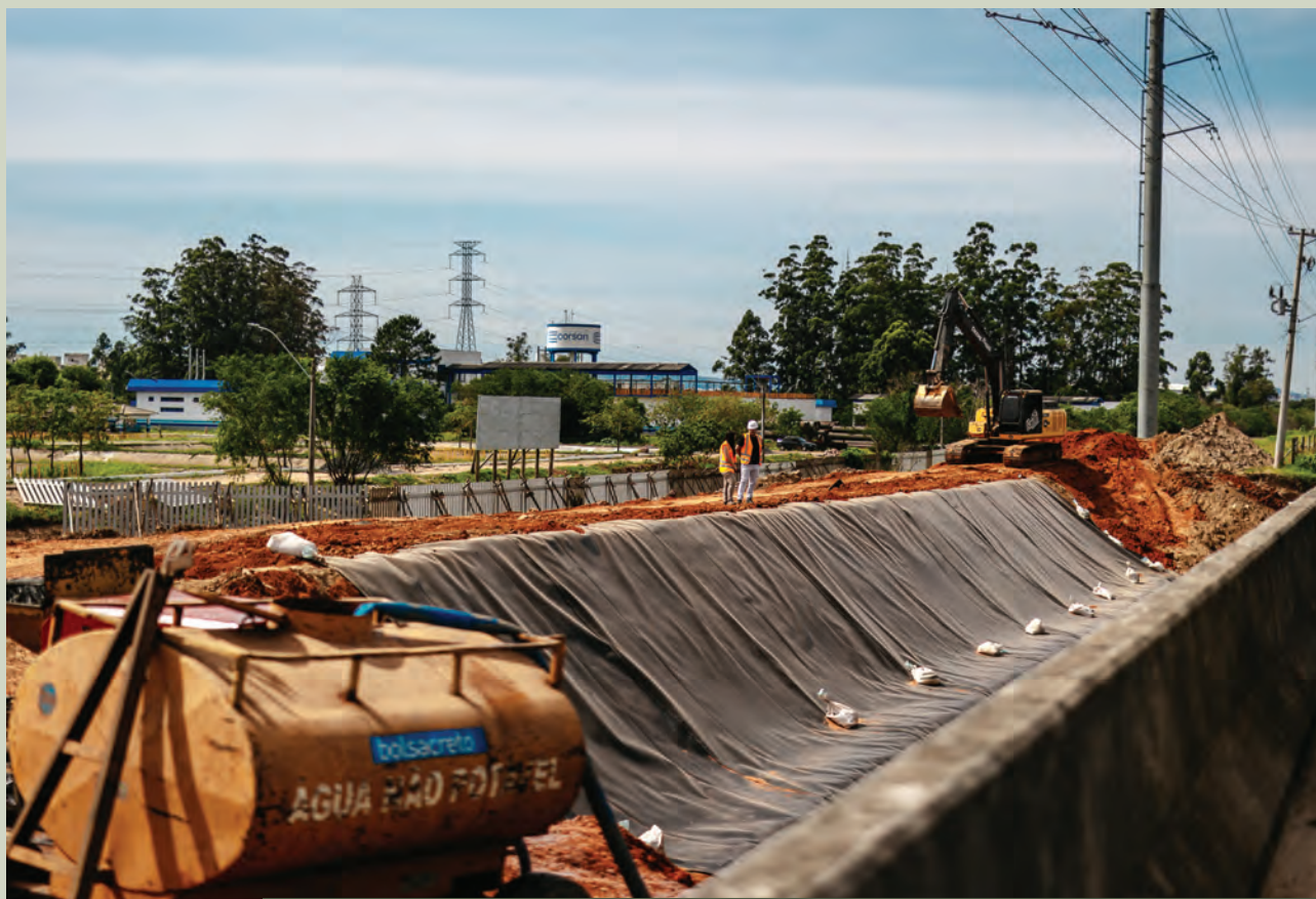
Reparo no dique da Mathias Velho em Canoas, RS, após a enchente.
