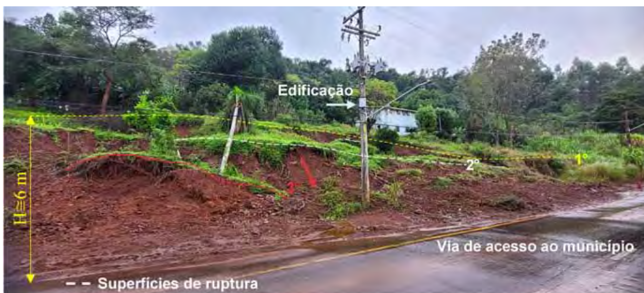
Figura 21. Exemplo de avaliação dos taludes
