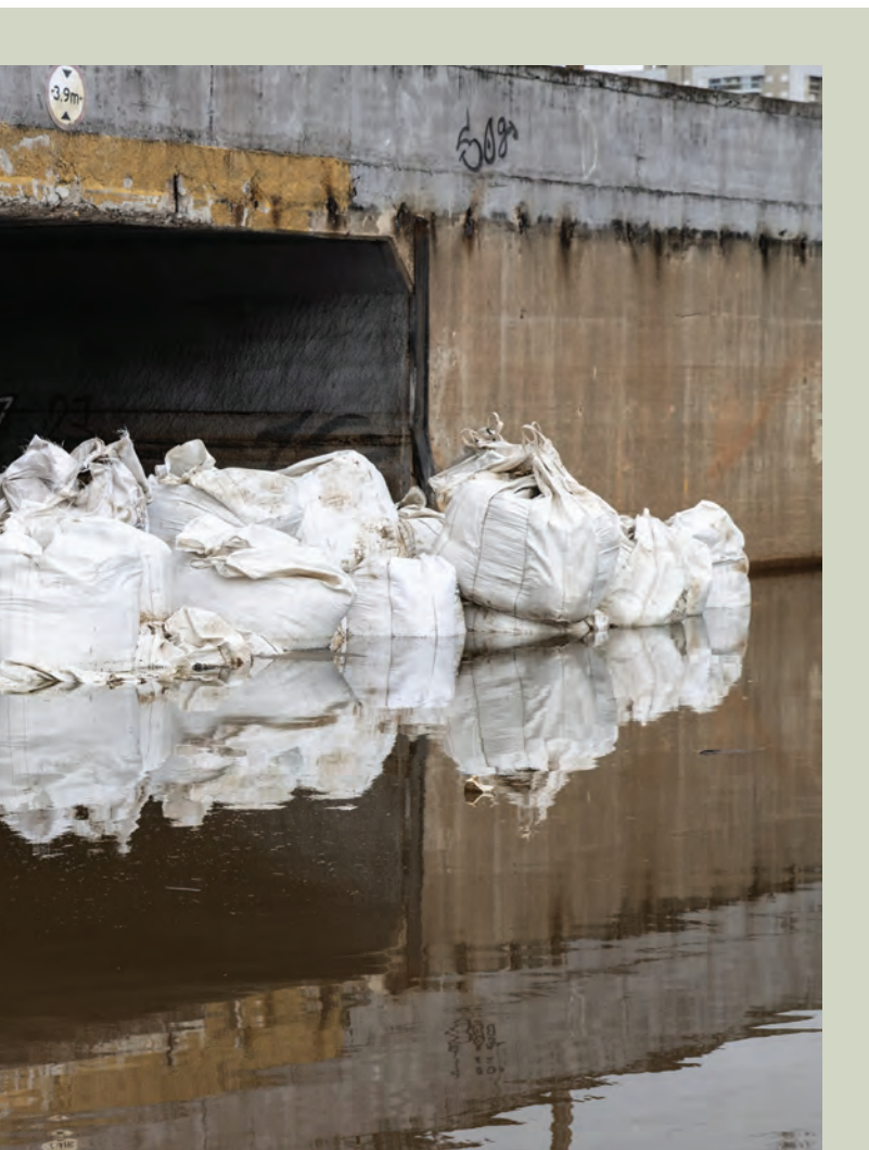
Reforço nas comportas do Guaíba durante a enchente de 2024.
